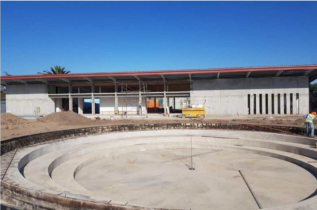
Foto 25: Interior del nuevo Estadio La Montura y pista de patinaje
