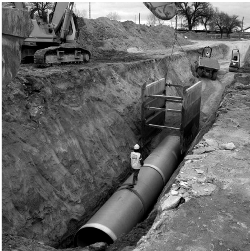
Foto de instalación de colectores de aguas servidas
